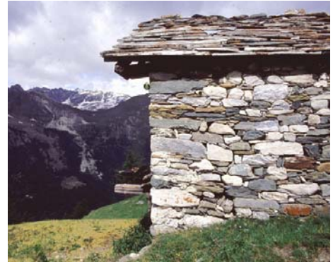
Sotto la funivia: i vecchi alpeggi approfittano largamente dei bei blocchi squadrate di calcare triassico, roccia che più su forma le Cime Bianche.
